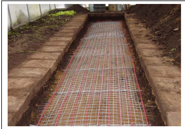
Рис. 3. Монтаж нагревательного кабеля deviflex™ DSIA-25 в теплице и на открытой площадке.
