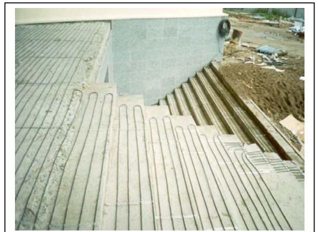
Рис. 4. Монтаж нагревательного кабеля deviflex™ DSOT на лестнице.
