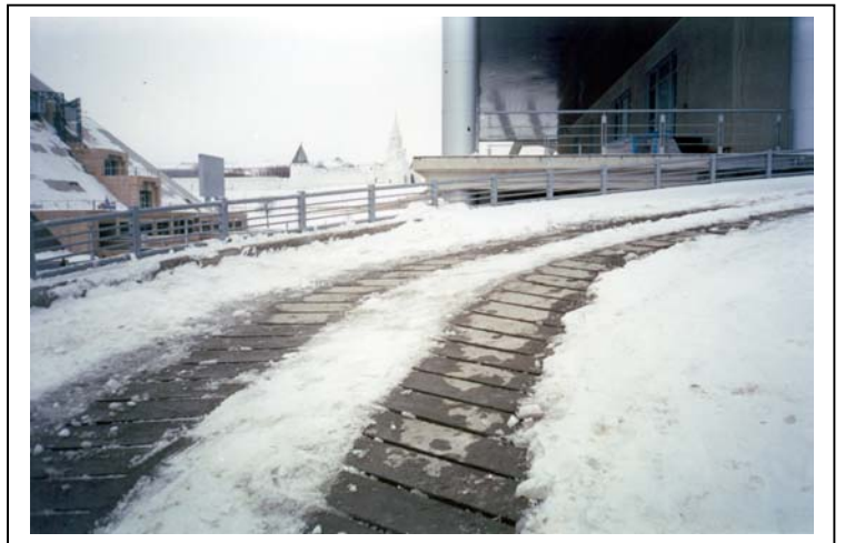
Рис. 3. Монтаж нагревательного кабеля deviflex™ DSOT на открытой площадке.
