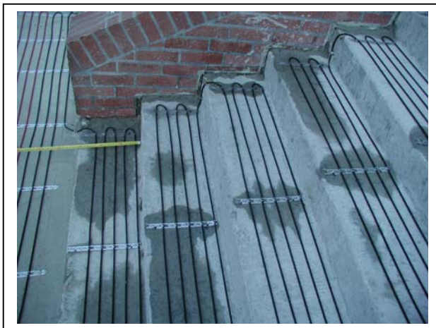
Рис. 4. Монтаж нагревательного кабеля deviflex™ DSOT на лестнице.
